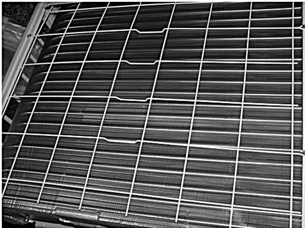
Рис. 1.3. Вид на конденсатор-радиатор наружного блока
