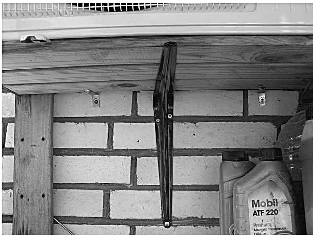
Рис. 3.4. Метод установки консолей на лоджии
