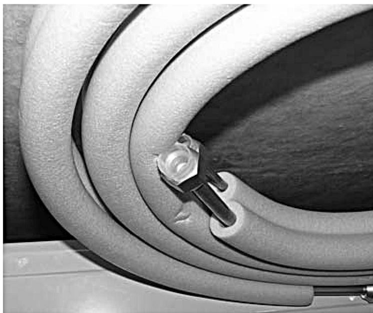
Рис. 3.12. Вид на контрагайки соединительных патрубков
