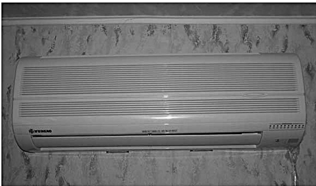
Рис. 3.8. Окончательный вид установленного на панели крепления внутреннего блока кондиционера Huagaо KFR25W/SV.
