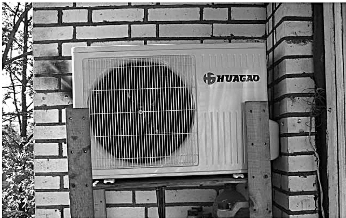
Рис. 3.3. Способ установки выносного блока непосредственно на лоджии
